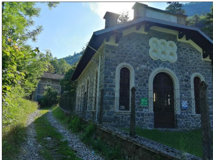
Figura 3. Centrale idroelettrica Enel Green Power Villa d'Ogna
